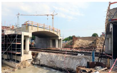
Wo bis vor kurzem noch das Kreuzungsbauwerk des Berliner Außenrings stand, klappt eine Lücke. Die neuen Bauwerksteile sind aber bereits fertiggestellt. Die Fernbahnseite (rechts) wurde bereits in Endlage errichtet und der Brückenteil für die S-Bahn (links) wird für den Verschiebung an die ergänzende Bauwerkshälfte vorbereitet (Juli 2018) [Quelle: DB Netz AG]
