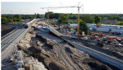
Am Karower Kreuz wurden in 52 Tagen Sperrpause drei Brückenteile mit jeweils mehr als 3.000 Tonnen Eigengewicht verschoben, 20.000 Tonnen Stahlbeton verbaut, 75.000 Tonnen Erde sowie 25.000 Tonnen Schotter und Gleise bewegt. Am frühen Morgen des 17. Augusts 2018 hat sich gezeigt, dass sich die Mühe gelohnt hat: Die neuen Kreuzungsbauwerke gingen in Betrieb und Züge der S-Bahnlinie 2 fahren wieder ohne Unterbrechung über das Karower Kreuz (1) [Quelle: DB Netz AG]
