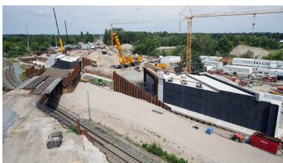
Am 18. Juli 2018 wurde am Kreuzungsbauwerk „Verbindungskurve“ der Brückenteil für die S-Bahn in seine Endlage verschoben (Juli 2018) [Quelle: Contempo Zeitrafferfilmproduktion]
