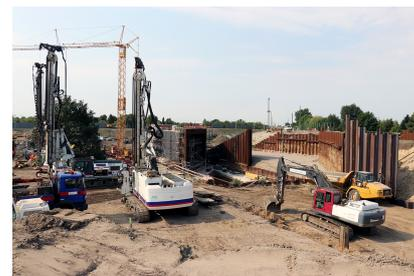
Vor wenigen Tagen fuhren hier noch Züge der Berliner S-Bahn, nun ebnen Bagger den Weg für den Verschiebung der S-Bahnseite des Kreuzungsbauwerks Verbindungskurve. Bald werden beide Bauwerkshälften mit je 3.000 Tonnen Eigengewicht zusammengeschoben und gemeinsam eine Brücke bilden (Juli 2018) [Quelle: DB Netz AG]
