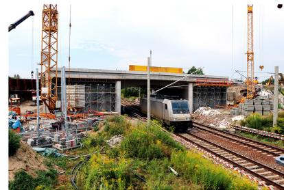
Bauen unter rollendem Rad: Auf dem Berliner Außenring fahren bereits wieder Züge und unterqueren dabei das neue Kreuzungsbauwerk. Derzeit wird der Bahndamm um die Eisenbahnbrücke wieder aufgefüllt. Dabei werden um das Bauwerk ca. 27.000 Tonnen Erde bewegt (August 2018) [Quelle: DB Netz AG]
