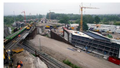
Bei Tag und bei Nacht: Am Karower Kreuz werden während der S-Bahn-Sperrung (26. Juni bis 17. August 2018) die Kreuzungsbauwerke fertiggestellt und verschoben (Juni 2018) (2) [Quelle: contempo Zeitraffer Filmproduktion]
