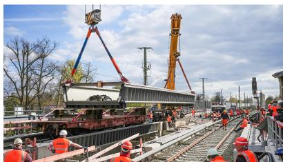
Am 24. April 2021 wurden die Überbauten für das innenliegende Fernbahngleis (Gleis 12) an der Eisenbahnüberführung „Pangrafenstraße/ Bahnhofstraße“ mit zwei Eisenbahndrehkränen eingehoben (April 2021) [Quelle: DB Netz AG/Oliver Lang]
