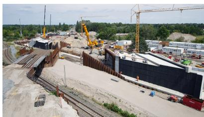
Der Brückenteil für die S-Bahn am Kreuzungsbauwerk „Verbindungskurve“ wird in seine Endlage verschoben (Juli 2018) [Quelle: Contempo Zeitrafferfilmproduktion]
