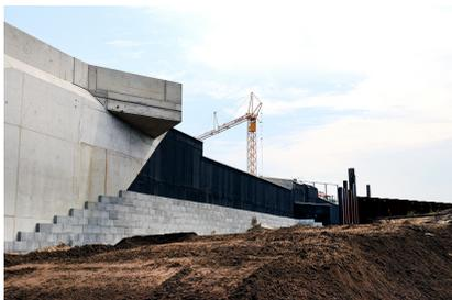
Nach dem Vershub der jeweils ca. 3.500 Tonnen schweren Brückenhälften versinkt das Kreuzungsbauwerk „Verbindungskurve“ langsam hinter den Erdmassen des neuen Bahndamms. Rund um die Eisenbahnbrücke werden insgesamt ca. 40.000 Tonnen Erde abgefahren bzw. aufgeschüttet (August 2018) [Quelle: DB Netz AG]
