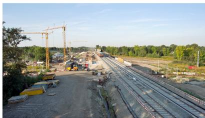
Am Karower Kreuz wurden in 52 Tagen Sperrpause drei Brückenteile mit jeweils mehr als 3.000 Tonnen Eigengewicht verschoben, 20.000 Tonnen Stahlbeton verbaut, 75.000 Tonnen Erde sowie 25.000 Tonnen Schotter und Gleise bewegt. Am frühen Morgen des 17. Augusts 2018 hat sich gezeigt, dass sich die Mühe gelohnt hat: Die neuen Kreuzungsbauwerke gingen in Betrieb und Züge der S-Bahnlinie 2 fahren wieder ohne Unterbrechung über das Karower Kreuz (2) [Quelle: DB Netz AG]
