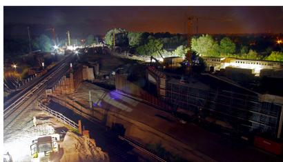
Bei Tag und bei Nacht: Am Karower Kreuz werden während der S-Bahn-Sperrung (26. Juni bis 17. August 2018) die Kreuzungsbauwerke fertiggestellt und verschoben (Juni 2018) (1) [Quelle: contempo Zeitraffer Filmproduktion]
